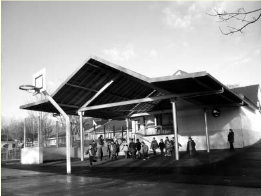
L'espace de jeux couvert au pignon du C.L.S.H., achevé en décembre 2003.
